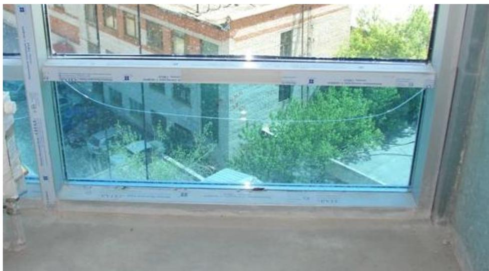
Рис. 3. Пример разрушения стекла в пакете из-за перепада давления и температуры.
