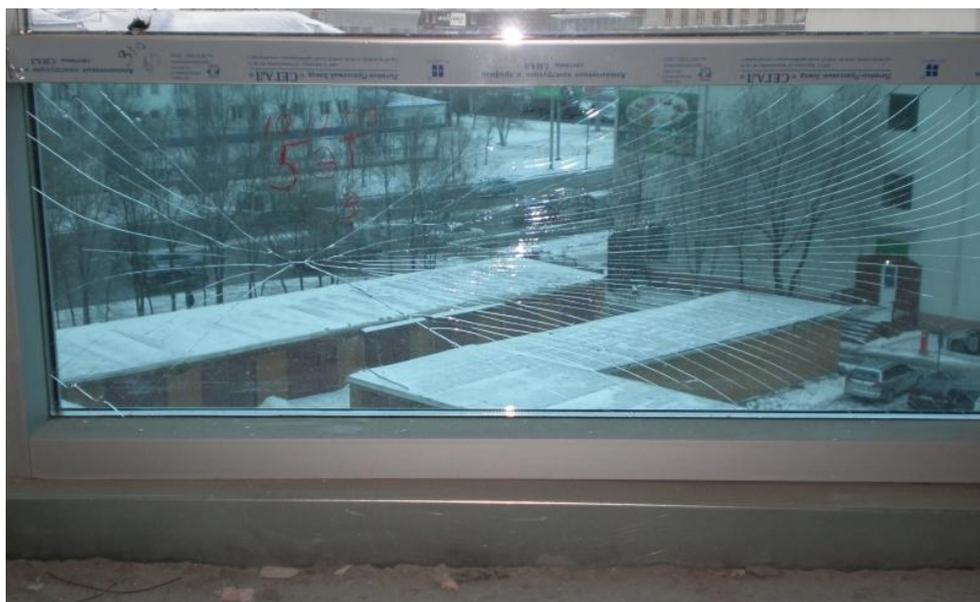
Рис. 4. Пример разрушения стекла в пакете из-за перепада давления и температуры.
